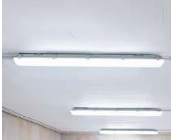
Deckenfeuchtraumleuchte LED in Garage und Keller
